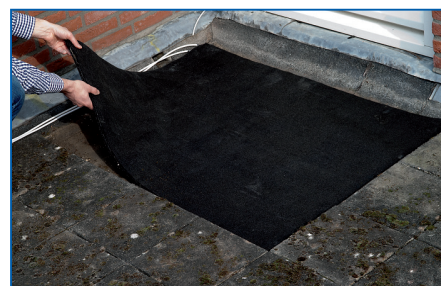
Detectiematten eenvoudig aan te leggen
